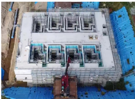
【岡山浄水場 No. 3 ろ過池】
