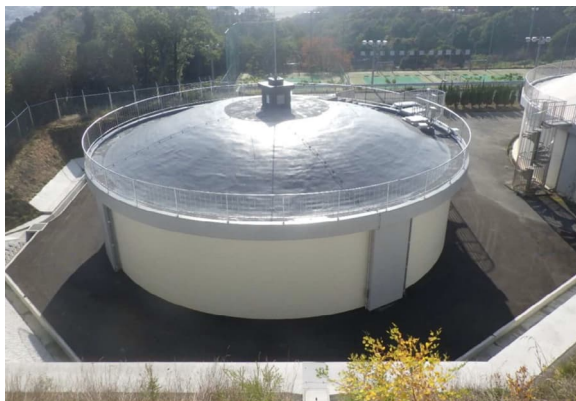
【総社第2調整池 左側増設 右側既設】
