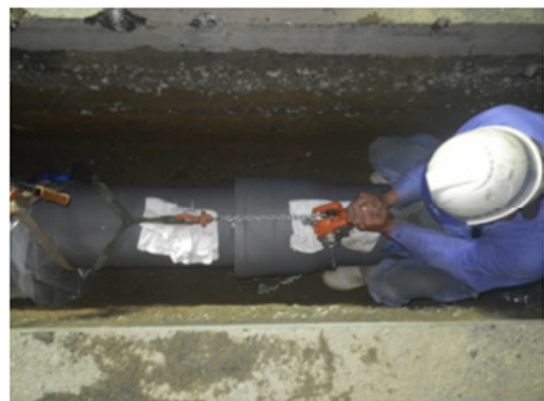
【岡山市瀬戸町線送水管 (GX耐震管)】
